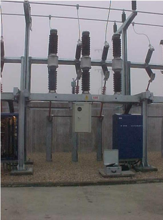
**72,5 kV. Montaje exterior. TI's incorporados**
